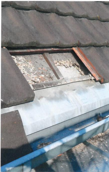
Bei ersten Probeöffnungen vor der Sanierung zeigte sich der Aufbau des Daches: eine Betonkonstruktion mit oberhalb liegender „Dämmung“ aus „Sauerkrautplatten“.
