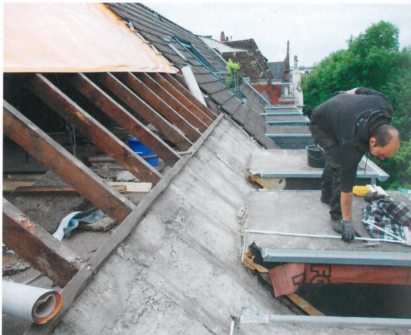
Nach dem Entfernen der alten Dämmung aus „Sauerkrautplatten“ lag die Betonfläche rund 60 mm hinter der Sparrenebene zurückversetzt.
