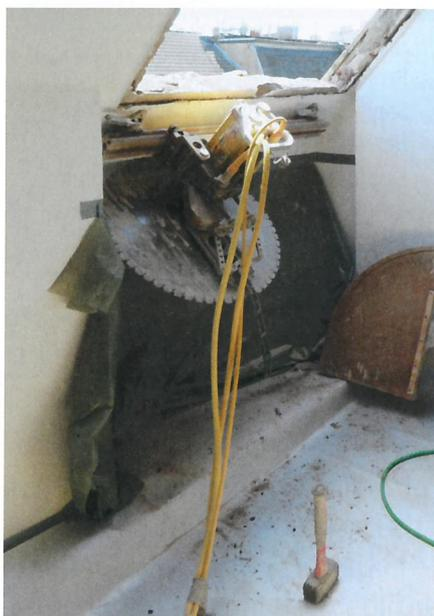
Für die Erweiterung der lichten Flächen im Dachbereich musste schweres Gerät in Form einer Betonsäge aufgefahren werden.
